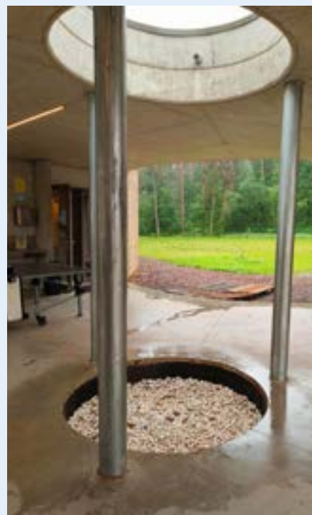
Het water stroomt centraal zonder regenpijp naar beneden.
